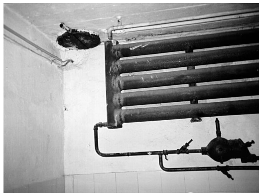
Detail 'gaskamer' Mauthausen op originele foto (1945). Let op plaats van de 'verwarming' (= koelsysteem!) boven in de ruimte en bediening (aan/uit) aan de binnenzijde. Ook de ventilatieklep (linksboven) is alleen binnen de 'gaskamer' te bedienen.
