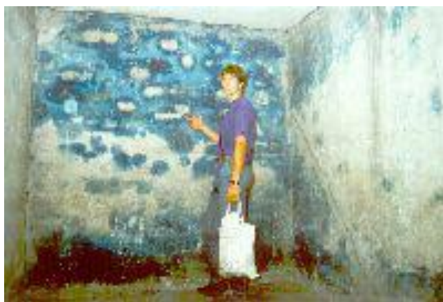
Pruisisch blauw op de binnenwanden van een Zyklon-B ontluizingsruimte.
