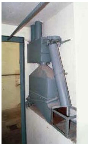
Verdampingsinstallatie in Zyklon-B kledingontluizingruimte.
