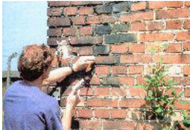
Pruisisch blauw, dwars door de muur van een ontluizingsruimte naar buiten gedrongen.
