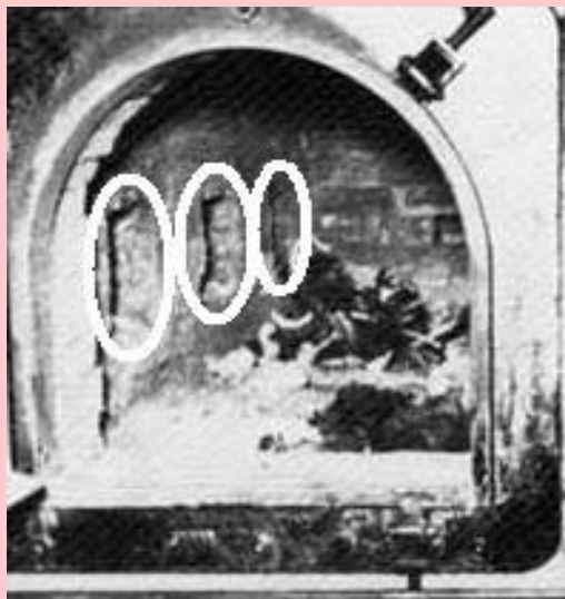
Crematieovens in Birkenau met verbindingsgaten voor de middelste van de drie crematiekamers. Bij meerdere lijken per ck wordt de interne doorstroming naar de middelste muffel verhinderd c.q. afgesloten.
