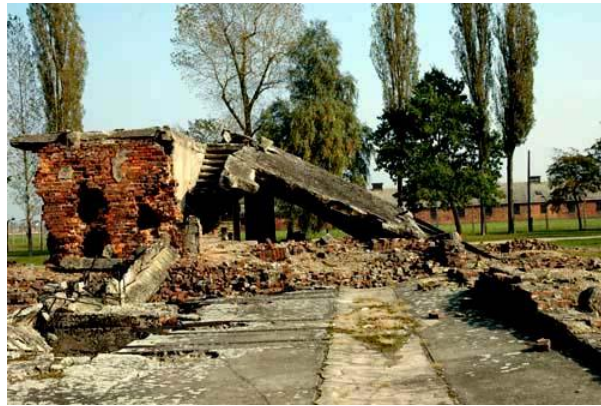
Restanten Krema II. Links gat naar de ruimte onder de ovens: de 'Vergasungskeller'?
