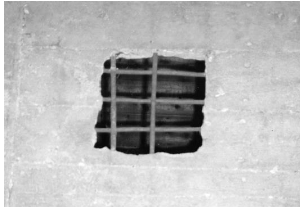
Later aangebracht gat in plafond 'gaskamer' B in Majdanek 'voor inwerpen Zyklon-B'
